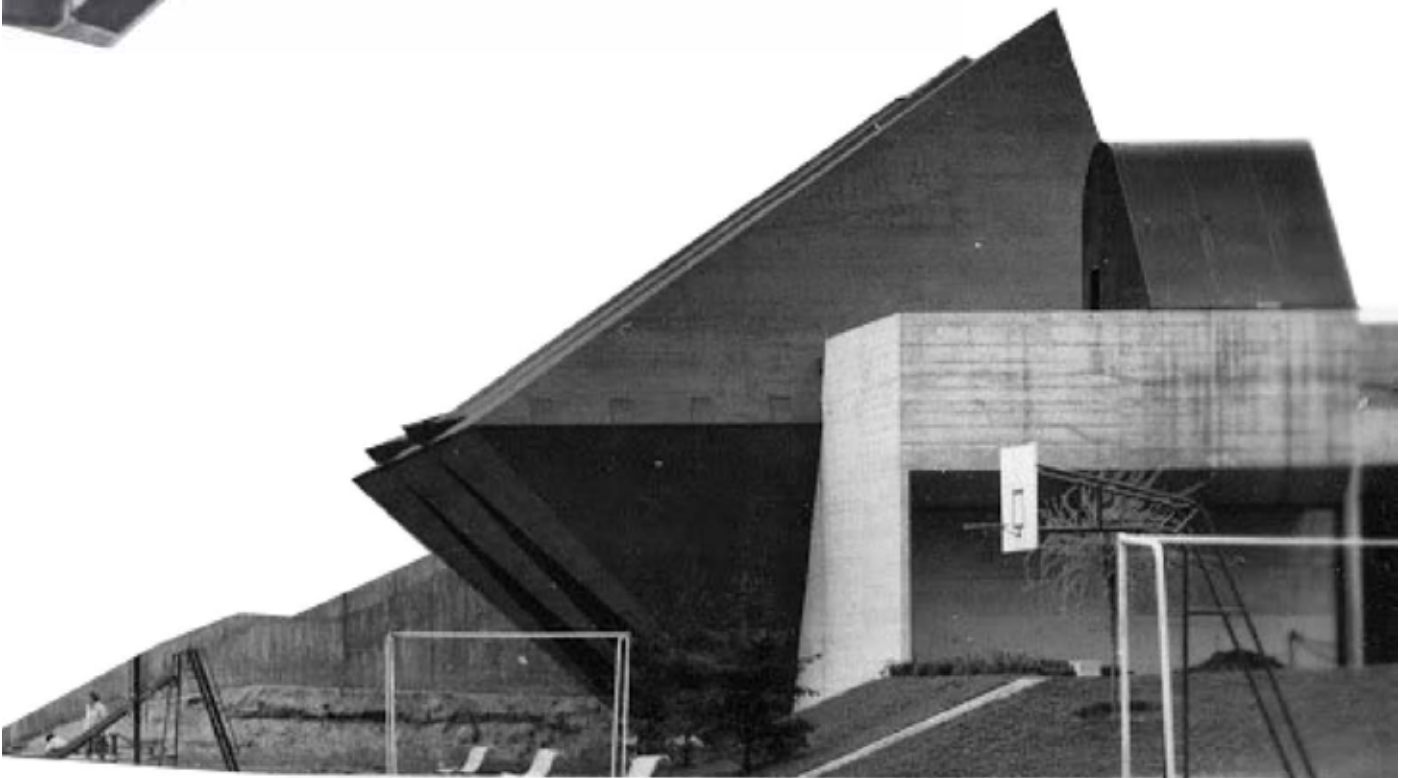
Chaufferie Rue des Pichets
