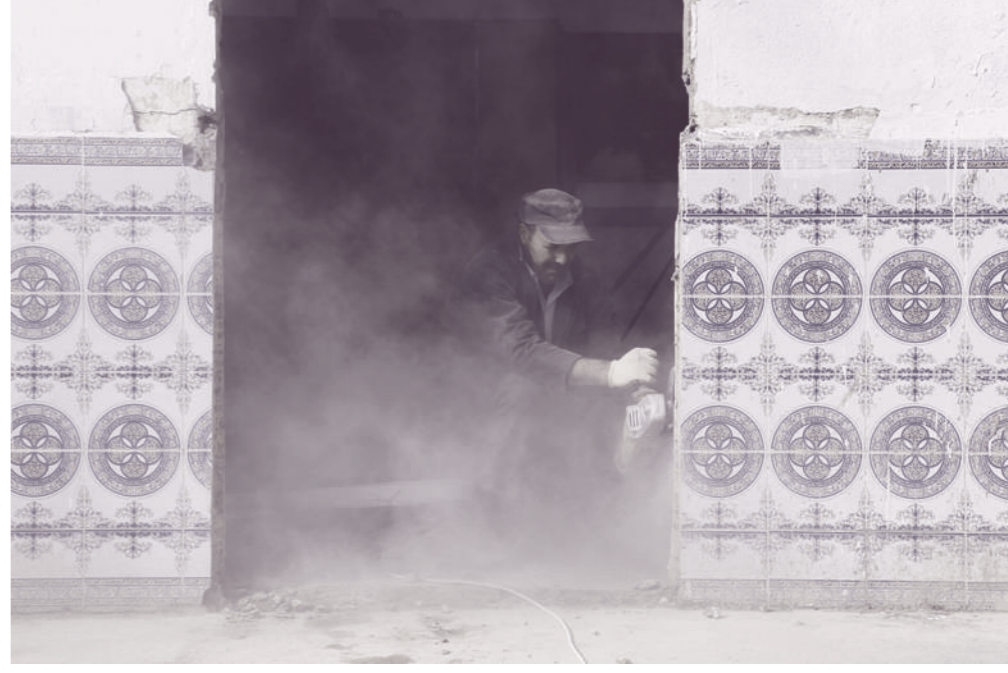
FR Chantier avec les artisans locaux, Qismi al Ahla, de l'école Bab Souika, médina de Tunis 2017 EN Construction site with local craftsmen, Qismi al Ahla of the Bab Souika school, Tunis medina 2017
