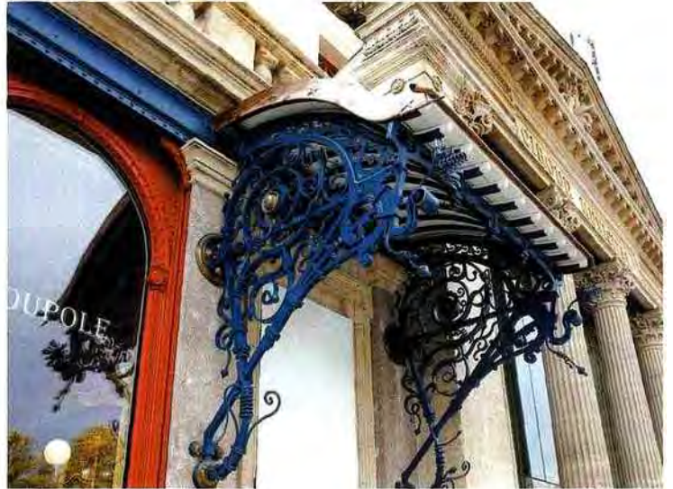
▼ Détruite par un obus en 1916, l'une des deux marquises en fer qui recouvraient les guichets a été entièrement recréée par un ferronnier d'art.
