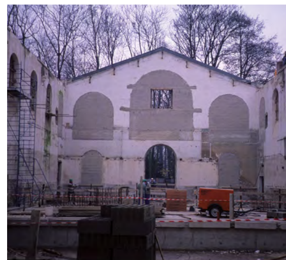
Travaux de restauration du Manège en 1989
