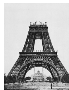
1888, construction de la Tour Eiffel
