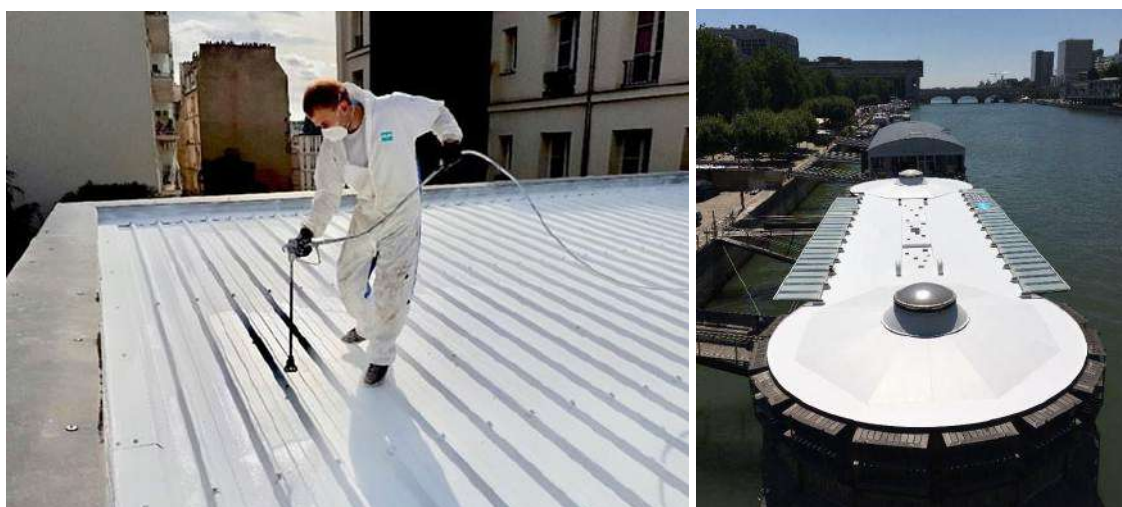
Application d'une peinture anti-chaaleur sur le gymnase Berlemont, 11 e . ; la péniche-hôpital Adamant, 13 e . (Crédits CoolRoof)
